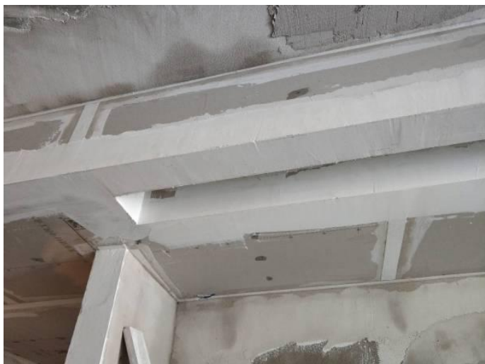
▲填充嵌缝石膏和粘贴纸带
